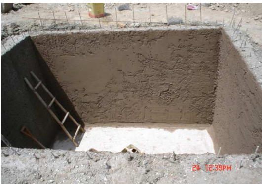
Construcción tanque de agua
